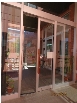
スロープ側の引き戸
